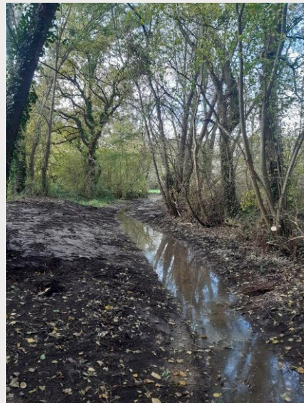
Boire reconnectée en fin de travaux après éclaircie des boisements et remodelage des sédiments
